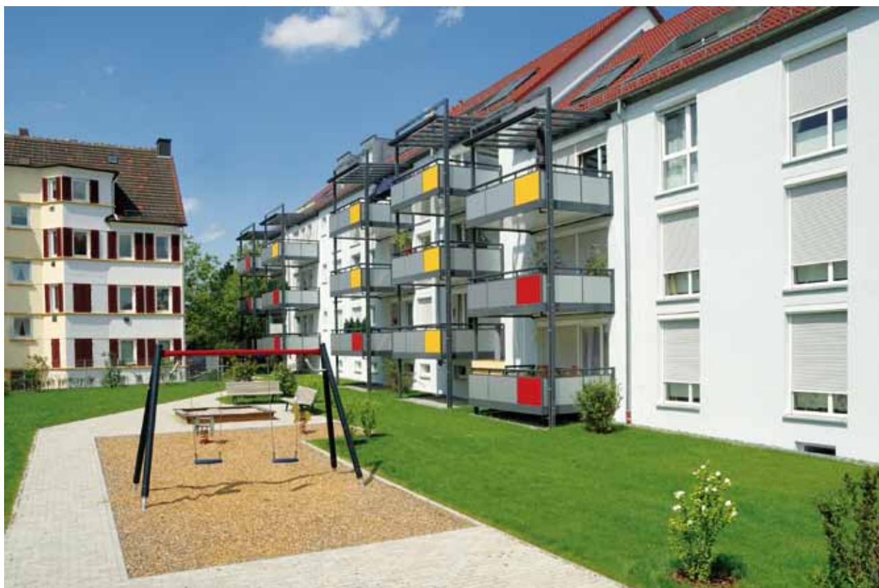
Baumannweg 4, Morstattweg 1 und 3
