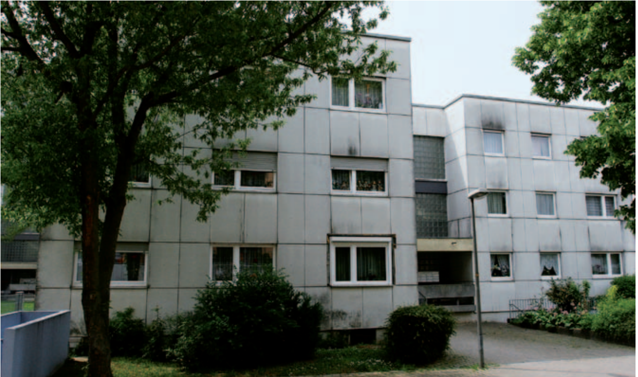
Marabastraße 16 vor der Modernisierung
