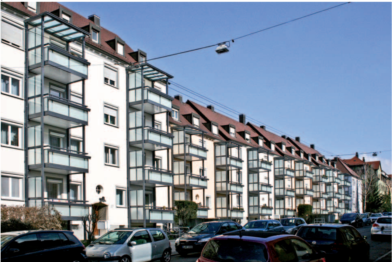
Die Häuser in der Kienbachstr. 27 bis 35 haben erstmalig Balkone erhalten.
