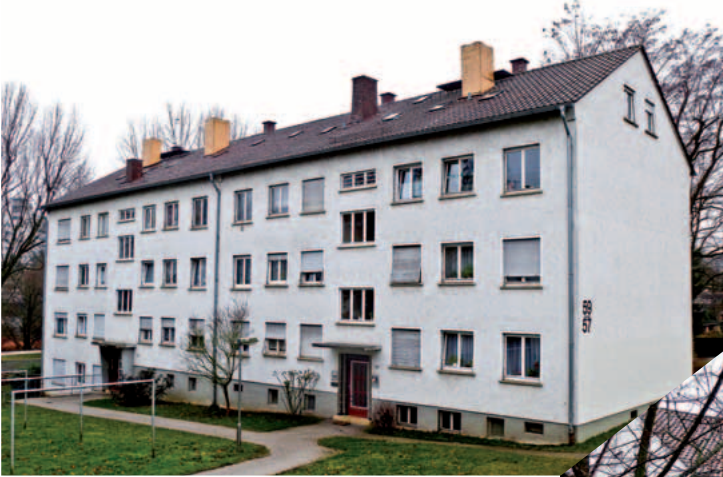
Die Gebäude in der Hechtstraße 45 bis 59 vor der Modernisierung.
