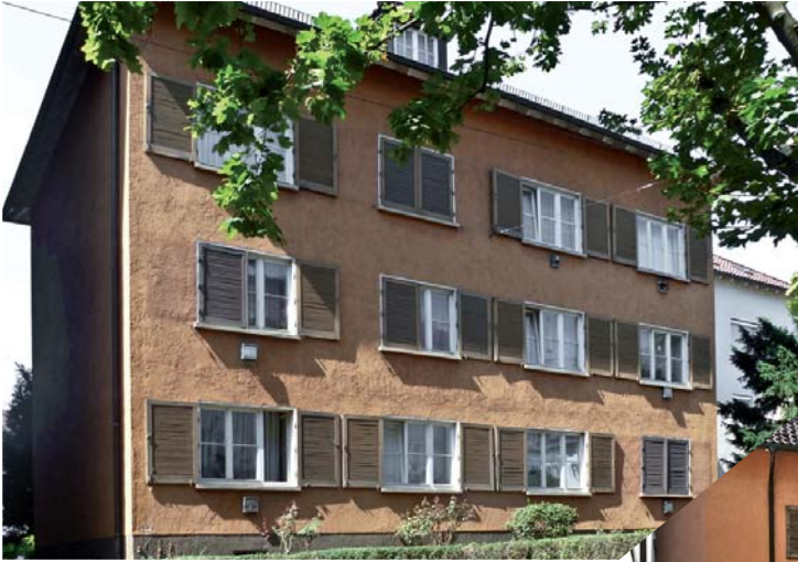
Das Gebäude Marienbader Straße 30 vor der Modernisierung.
