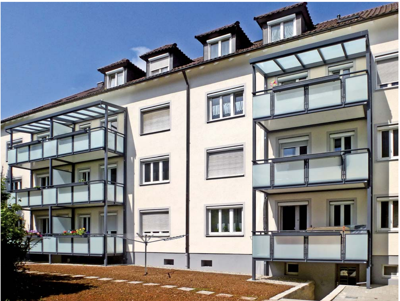
Die Gebäude in der Aberlin-Jörg-Straße 2 und 4 haben erstmalige Balkone erhalten.
