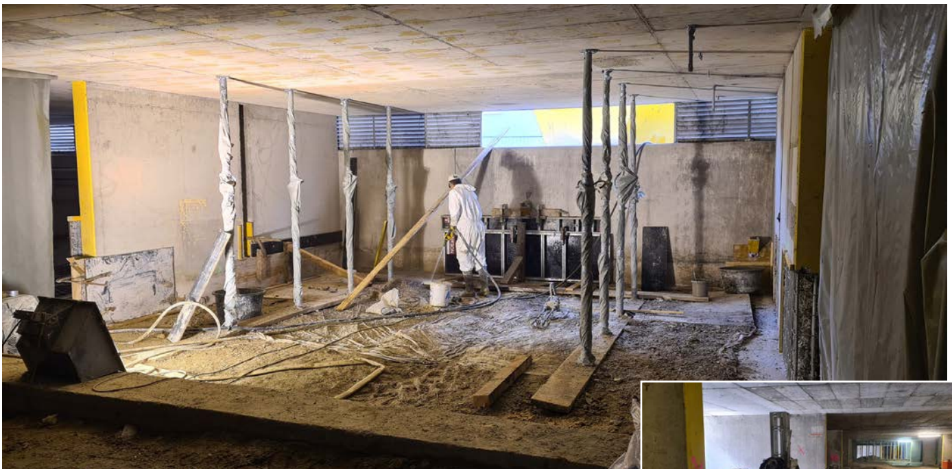
Die aufwendige Sanierung der Tiefgarage im Regenpfeiferweg 15 bis 21 schreitet voran.
