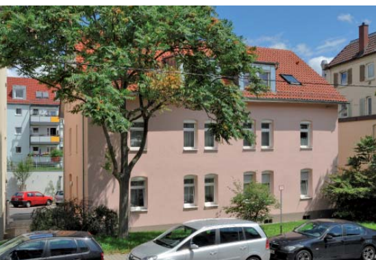
Das erste Gebäude der Genossenschaft: der Prießnitzweg 2 und 4
