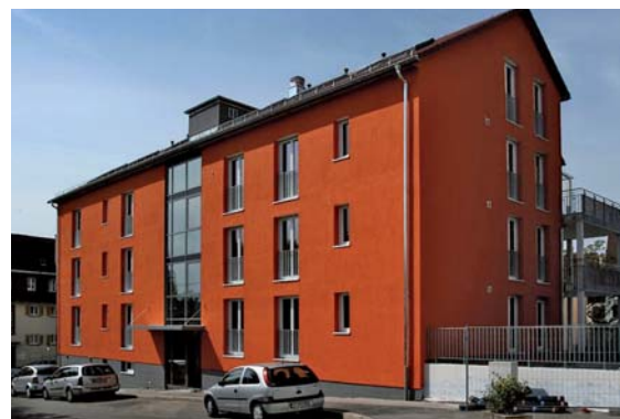
Wir bekennen Farbe: der Neubau in der Theodor-Veiel-Straße 1
